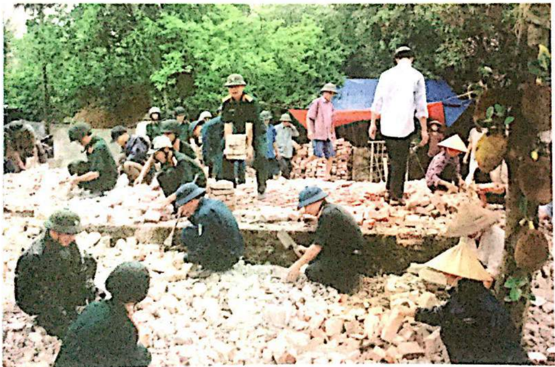
Cán bộ, chiến sĩ Lực lượng vũ trang huyện Hưng Hà giúp xây dựng nhà tình nghĩa cho Mẹ Việt Nam Anh hùng
